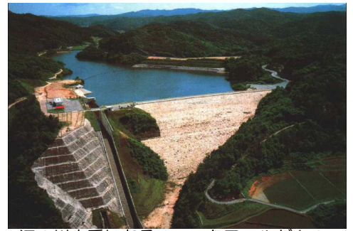
江の川水系にある、ロックフィルダムの目谷ダム。
