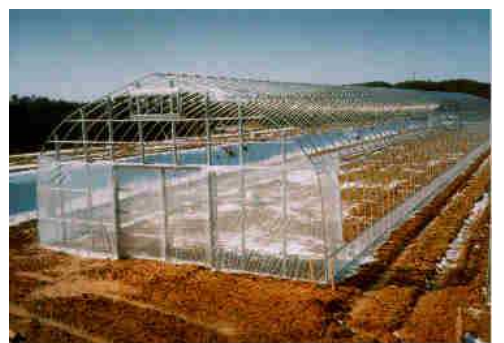
やっと1棟分の骨組みが完成。この後、シートを張って完成です。
