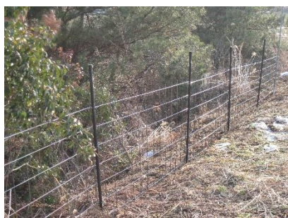
① 2011年3月22日 初期の防獣柵。 2mおきに柱を立て、金網を張りました。柱と柱の間にはペグを打って補強しています。
