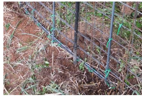
③ 2016年7月14日 鉄筋を使って柵を補強。 柱の間隔を50cmに狭くして、地際に直径13mmの鉄筋を這わせて、柵がめくれ上がらないようにしました。
