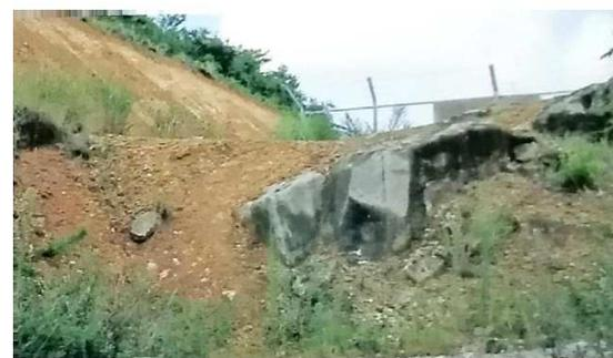
畑の造成時に出てきた、流紋岩の核岩。大きく硬いため、壊して取り除くことが出来ず、法面に突き出たままになっています。畑の周囲には、このような岩が沢山あります。
