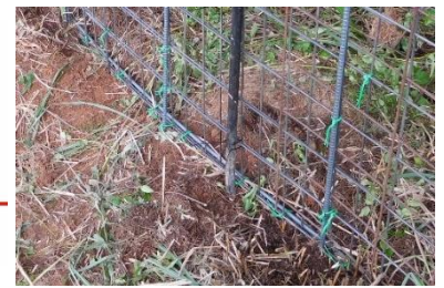
支柱の数を増やし、下を鉄筋で固定。
